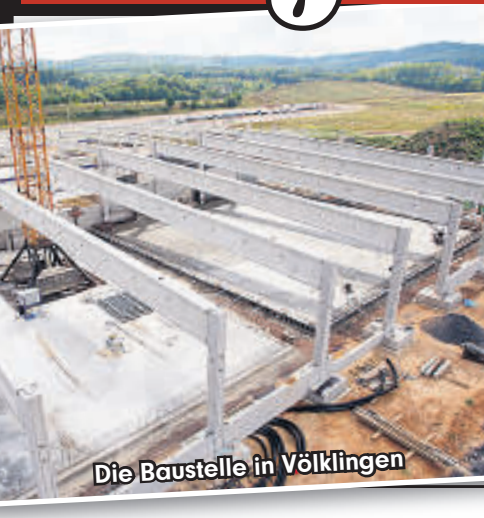
Die Baustelle in Völklingen
