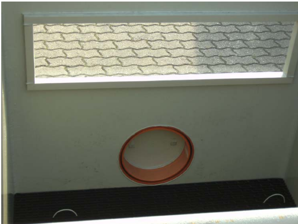
IRAS P 2 Twin Fenster Wohnbereich Innensicht
