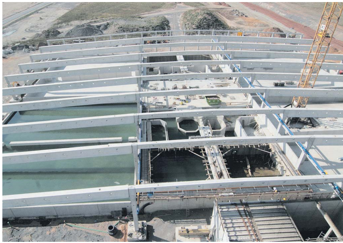
Die Becken der Fischzuchtanlage sind für Tests schon einmal befüllt worden. Foto: SZ/Stadtwerke
